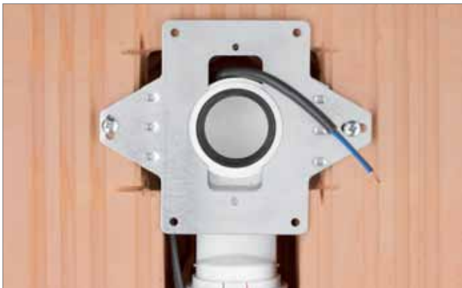
Şekil 5-3 Montajı tamamlanmış montaj çerçevesi
