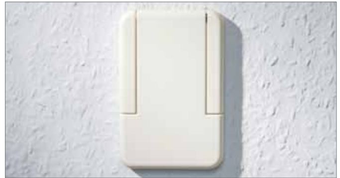
Şekil 5-5 Montajı tamamlanmış vakum prizi (uzaktan kumandalı sistem için)
