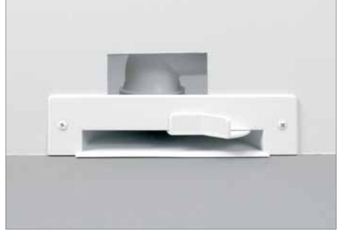
řekil 5-11 Vakum borusu bađlantısı (duvar önünden)
