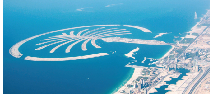
Shoreline Apartman-Kompleksi, Palm Island of Jumeirah, Dubai, Birleşik Arap Emirliği
